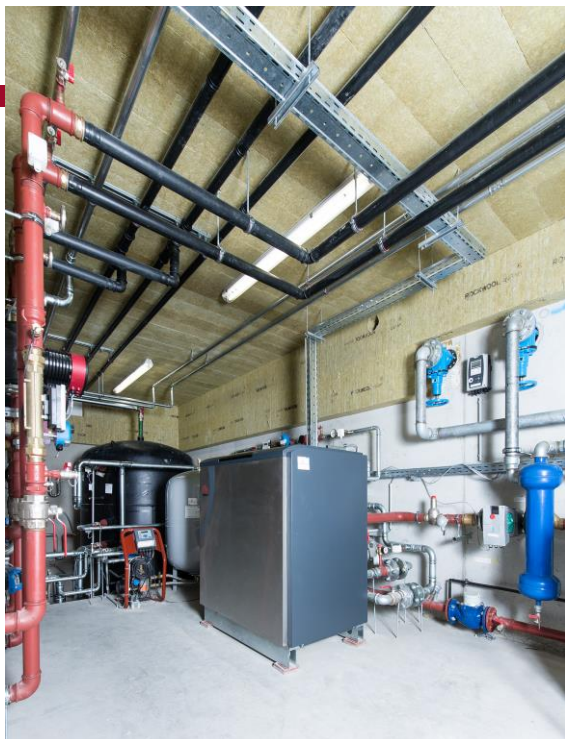
Grundwasserwärmepumpenanlage mit thermischer Solaranlage und Photovoltaik
